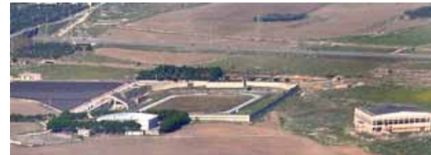
Il campo sportivo e il nuovo palazzetto abbandonati. (foto di Sandro Chiarista)
