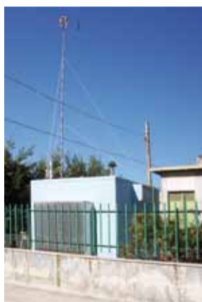
La stazione di monitoraggio di Via dei Mandorli
