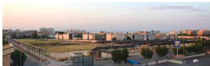
L'impianto fotovoltaico in area Eurospin
