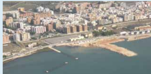
Il nuovo porto turistico in costruzione
